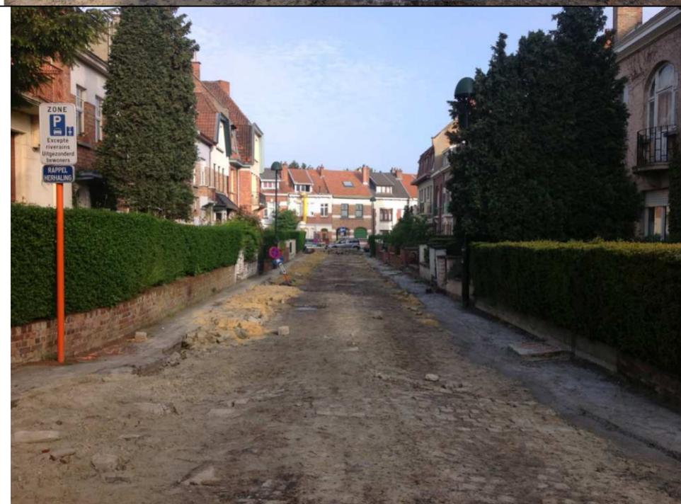
**Enlèvement des trottoirs (un côté de la rue et ensuite l'autre) et remplacement par une fondation en béton maigre sur une largeur équivalente au trottoir enlevé, permettant un passage au sec des piétons.**
