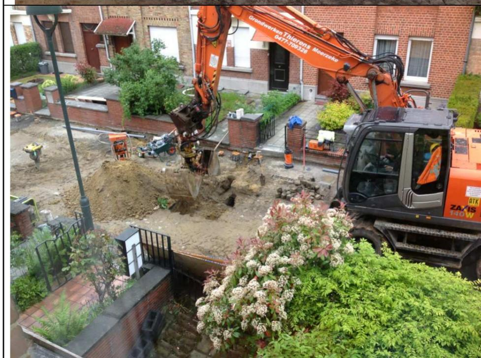
**Raccordement des gargouilles (c'est à dire les évacuations d'eau de pluie des toitures de certaines maisons qui se rejettent chez certains en voirie). Ce travail prend du temps vu la nécessité de creuser une tranchée jusqu'au collecteur principal d'égout.**
