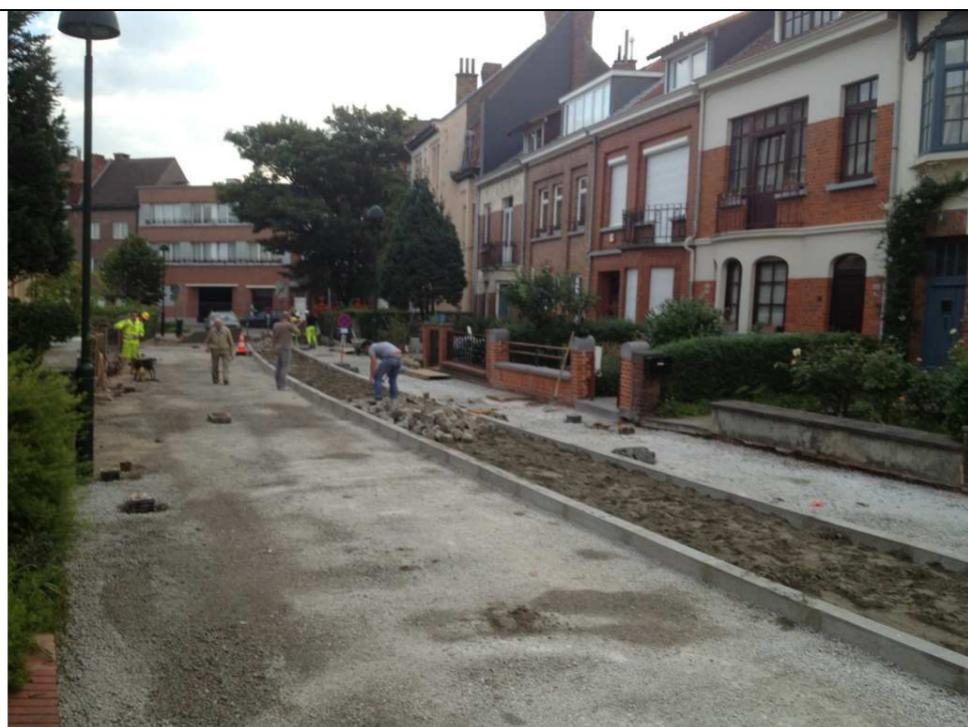
**Placement des pavés récupérés (en porphyre) dans les zones de stationnement.**
