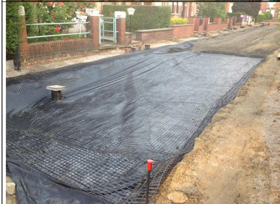
**Placement d'un géotextile et géogridde (renforcement des sols et de leur portance).**
