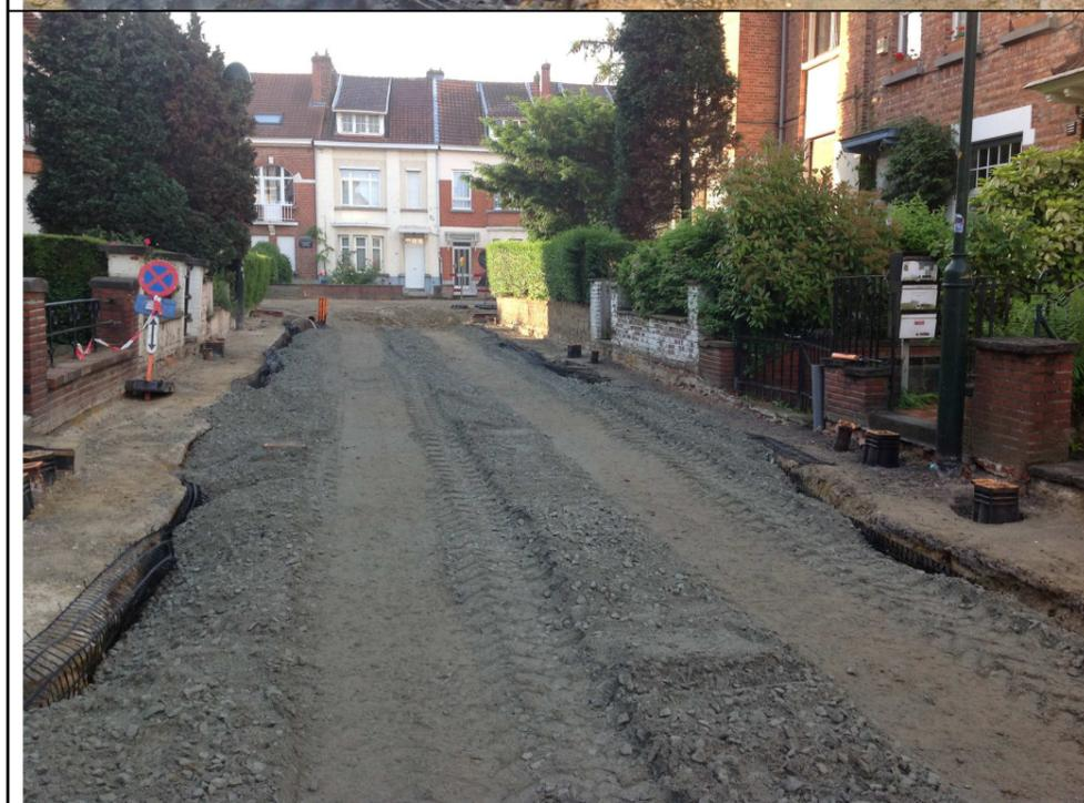
**Placement de la fondation en béton drainant.**
